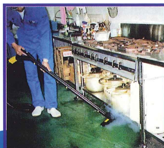
● 厨房周辺の床を、洗剤を併用して高温スチーム+ブラシ洗浄。
